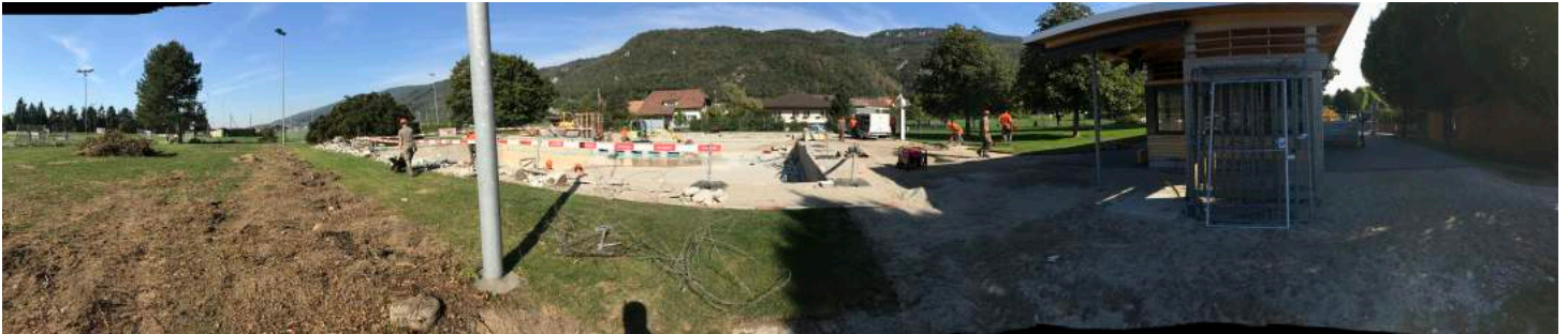
Abb.5: Panoramablick auf die Baustelle
