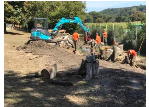
Abb.2: Arbeiten am Bach
