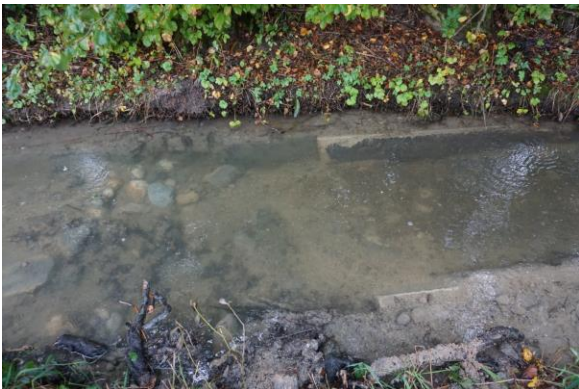
Abbildung 1 - Betonelemente am Bachbett
