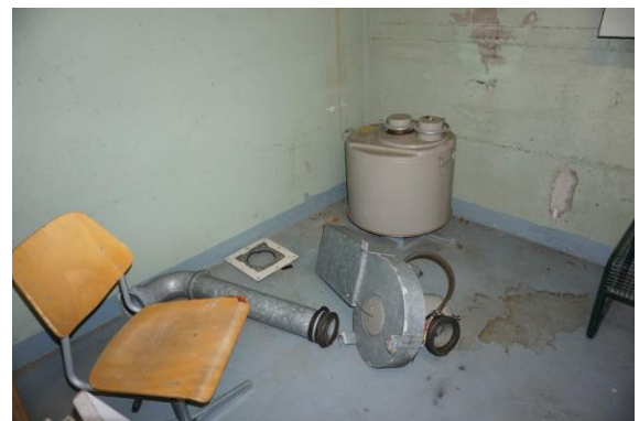
Abbildung 4 - Abgebautes Lüftungsaggregat
