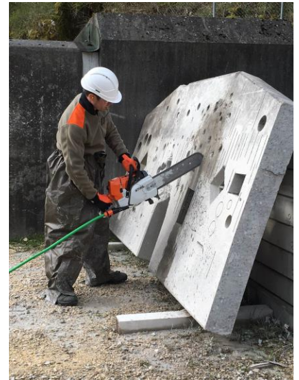
Abb4 Stihl-Eisen-Beton-Kettensäge wassergekühlt
