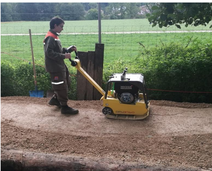
Abbildung 3: Arbeit mit der Vibrationsplatte, um den Untergrund wieder zu festigen
