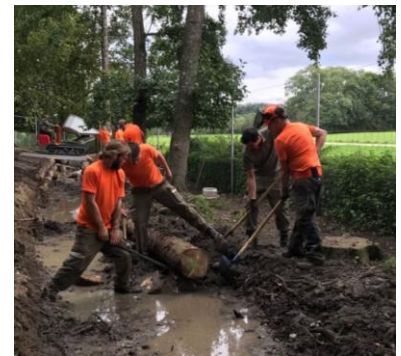
Abbildung 1: Die schweren Baumstämme müssen verankert werden
