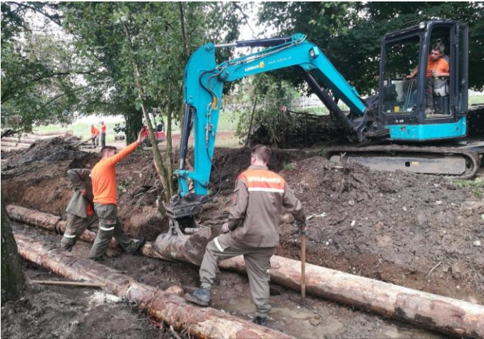
Abbildung 2: Mit Hilfe eines Baggers werden Stämme an ihren Platz gebracht
