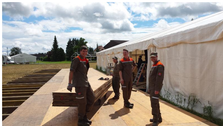
Abbildung 1: Die Pioniere beim Verlegen der Holzböden
